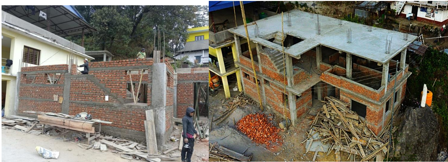
मैवाखोला मा.वि. तेम्बेको निर्माणधिन ८ कोठे भवन
