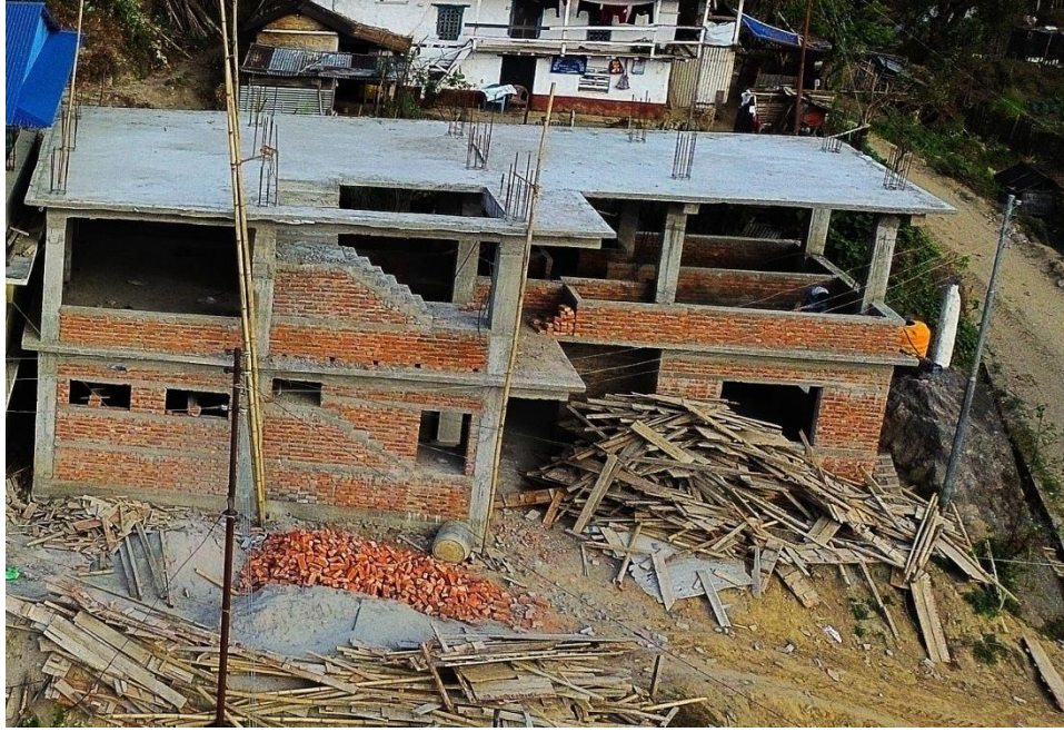
वडा नं. २ निर्माणाधिन १५ सैँया अस्पताल
